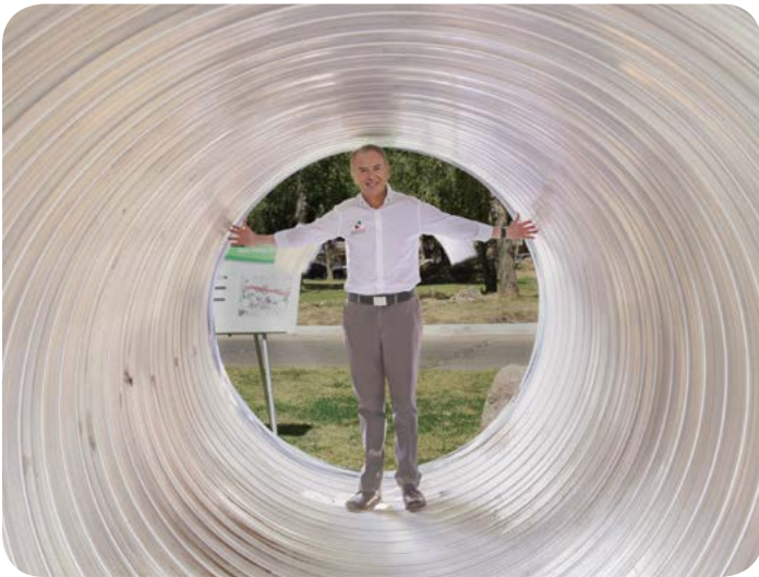
Supervisión del dren central en el río Santiago.
