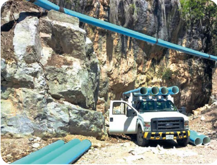
Construcción del acueducto La Maroma.
